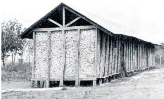
**Figura 2.** Almacenamiento en condiciones que favorecen buena ventilación y secado
