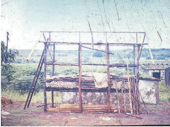
**Figura 4.** Construcción rústica para el secado del maíz por aireación natural y exposición al sol.
